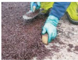
7.-Utilice un taco de madera para obtener el espesor deseado.
