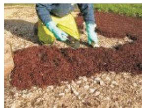
5.-No necesitamos herramientas pesadas . Use una plana llana para arrastrar y compactar el material.
